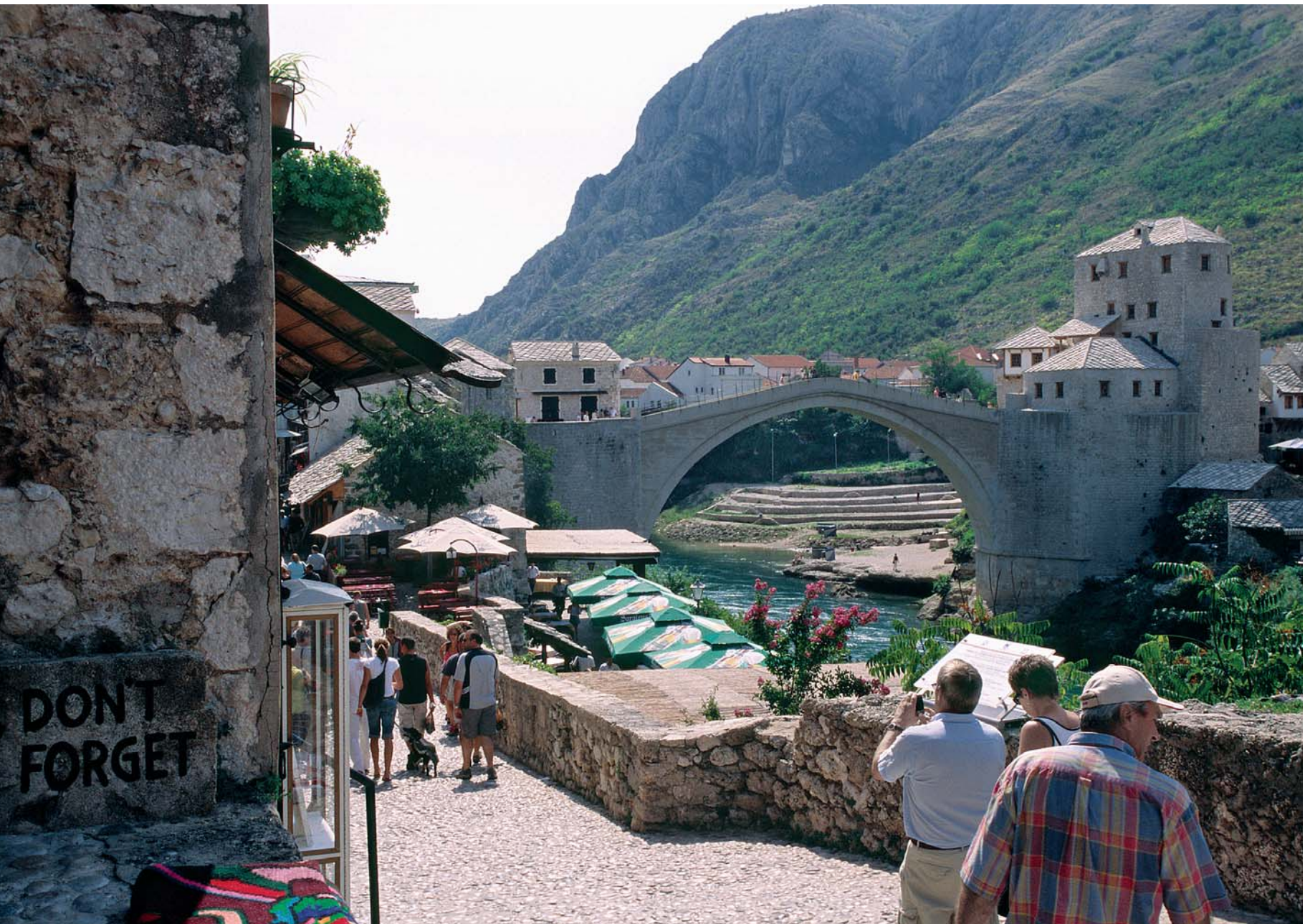
il nuovo ponte di Mostar ricostruito identico al precedente, con pietre prese dalla stessa cava
